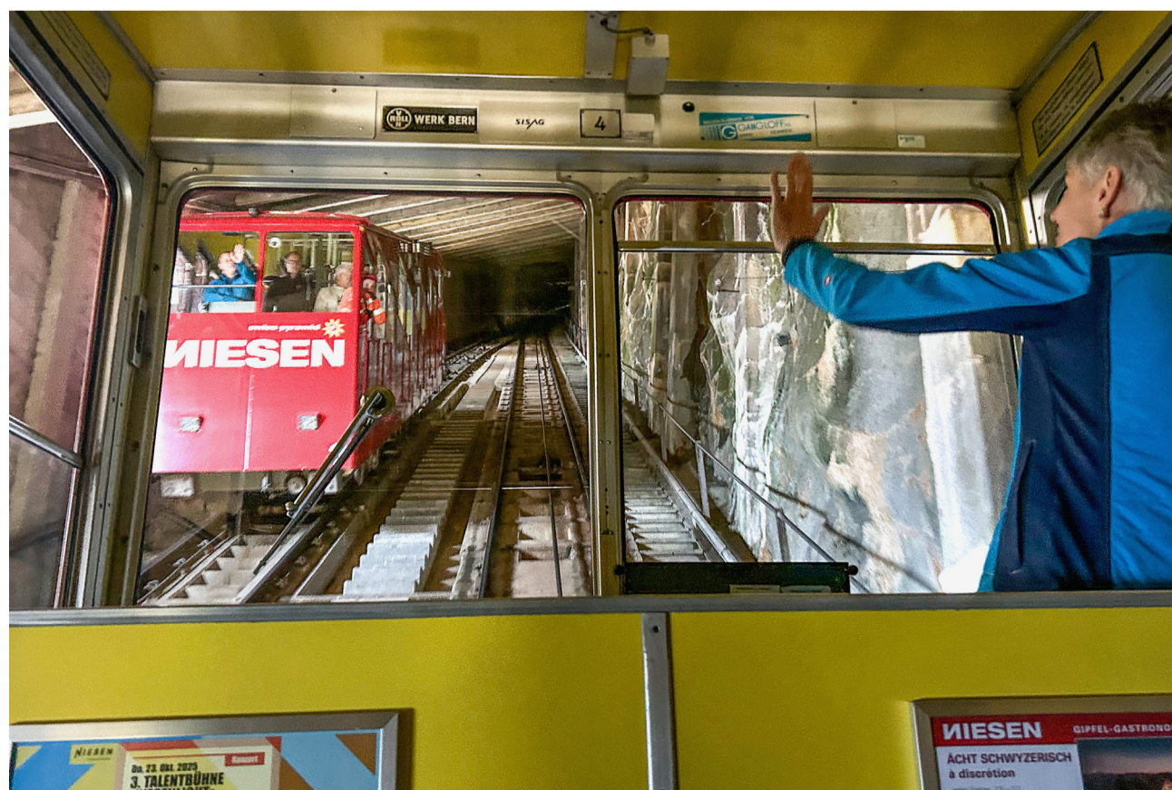
Die Infrastruktur der Niesenbahn – hier kreuzen die Kabinen in einer Galerie – benötigen intensiven Unterhalt.
