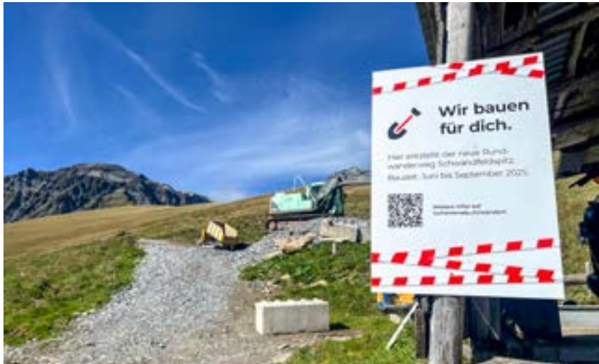
Die neue Rundwanderweg-Teilstrecke vom «Oester-Stafel» hinauf zum Schwandfeldspitz ist im Bau.
