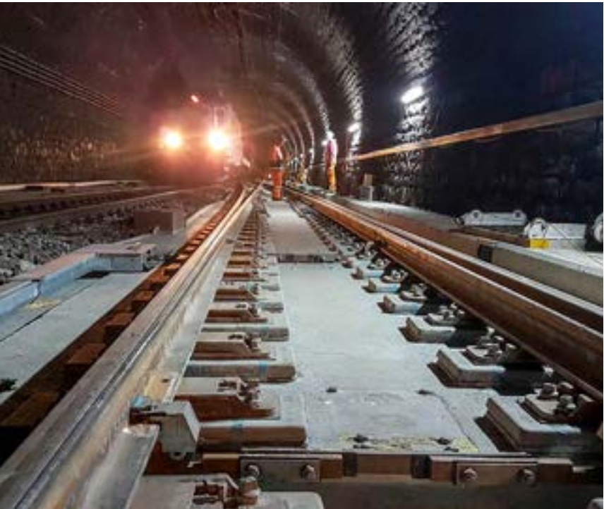
Bild vom Einbau der neuen Betonfahrbahn im Lötschberg-Scheiteltunnel – an zwei Stellen muss diese repariert werden.
