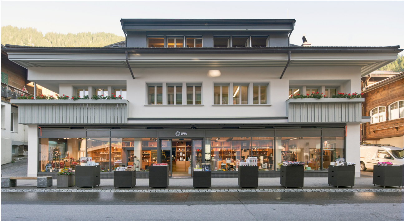
Das Geschäftsgebäude des Licht- und Wasserwerks mitten im Adelbodner Dorfkern
