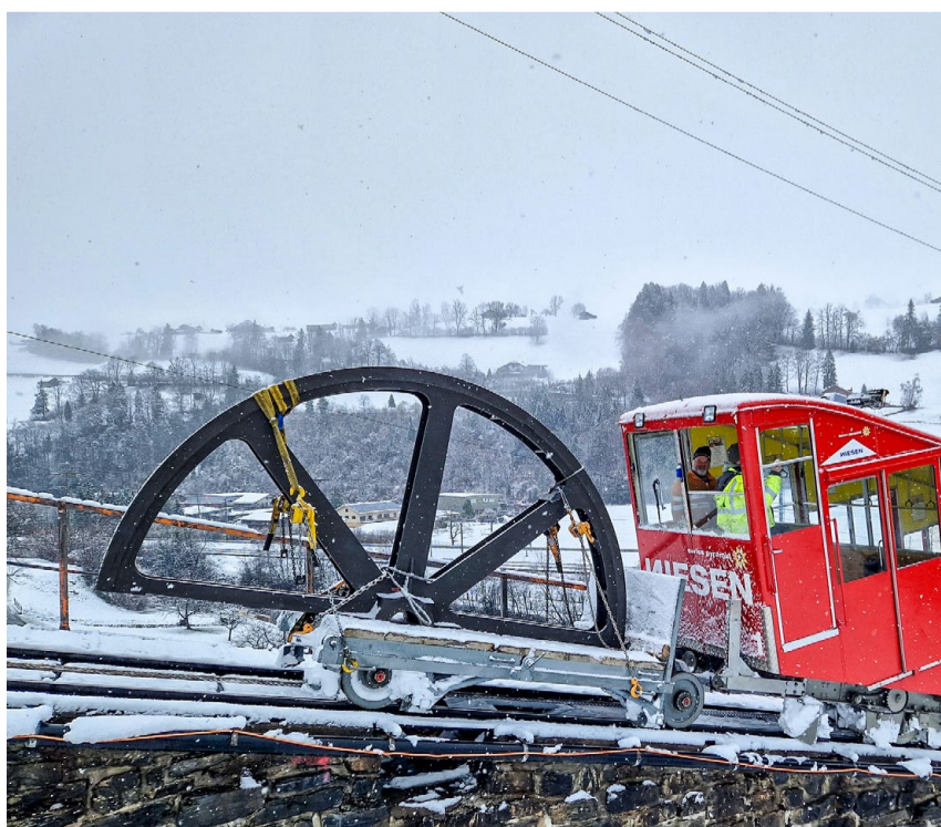
Diese 1980 Kilo schwere Gegenrad-Hälfte wurde am Mittwoch hinabtransportiert.
