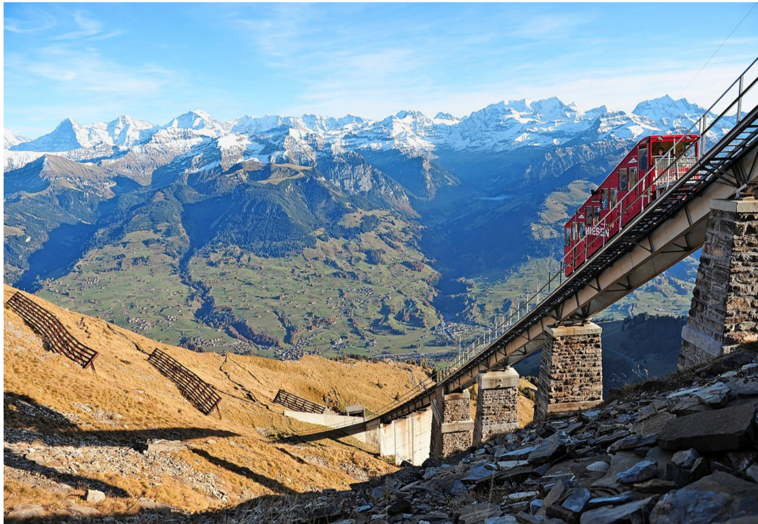
Der Bahnbetrieb verbraucht jährlich rund 350'000 Kilowattstunden Strom: Obere Sektion der Niesenbahn auf dem Hegernviadukt. Foto: Bruno Petroni
