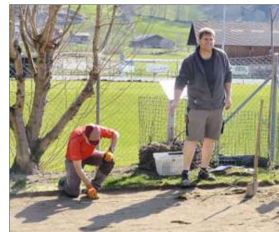
Beat Bieri und Bernhard Fähndrich starteten mit den Arbeiten für die Schaukel.
