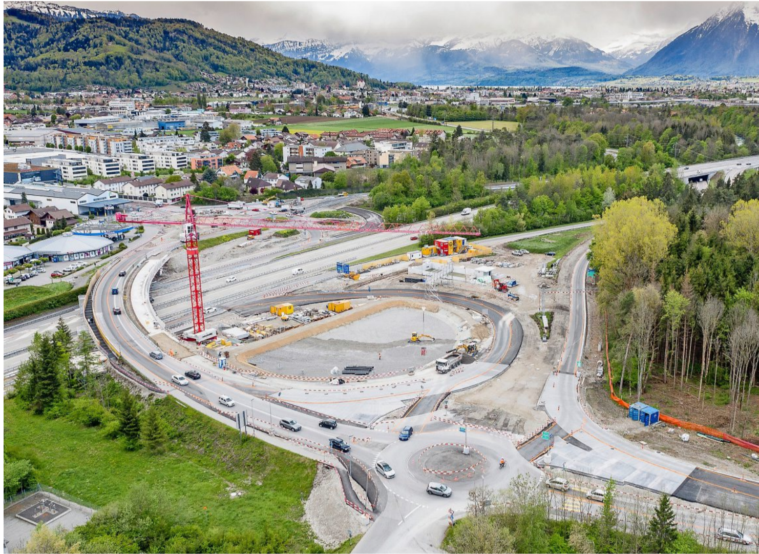
Die Baustelle am Autobahnanschluss Thun-Nord aus der Vogelperspektive. Foto: Christoph Gerber
