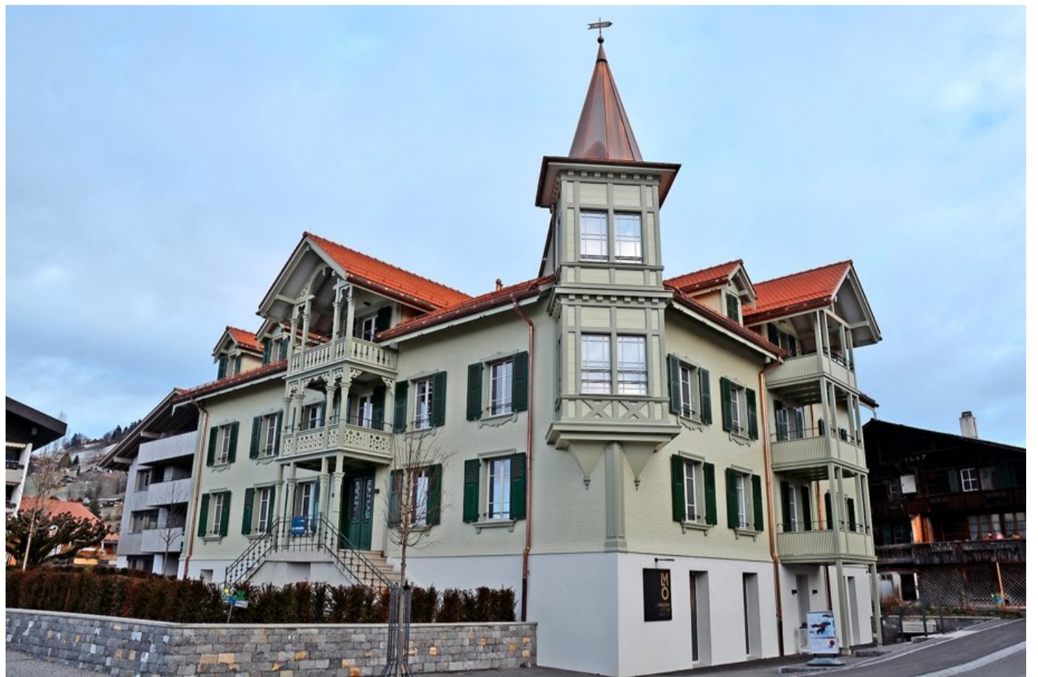
Die ehemalige Dépendance des Hotels Bären in Sigriswil ist fertig renoviert und erinnert an die Tourismusgeschichte.
