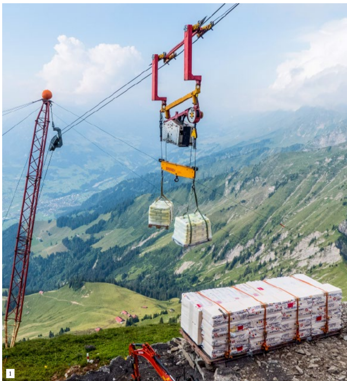
1: Der Um- und Ausbau auf dem Niesen ist nur dank der Materialseilbahn mit fünf Tonnen Tragkraft möglich. 2: Ein kleiner Bagger schichtet im steilen Gelände auf der Wimmisseite des Gipfels den Aushub auf. 3: Markus Rubin koordiniert auf Seiten der Niesenbahn die Arbeiten der speziellen Baustelle. 4: Der Installationsplatz seitlich neben dem Berghaus. BILDER HSF
