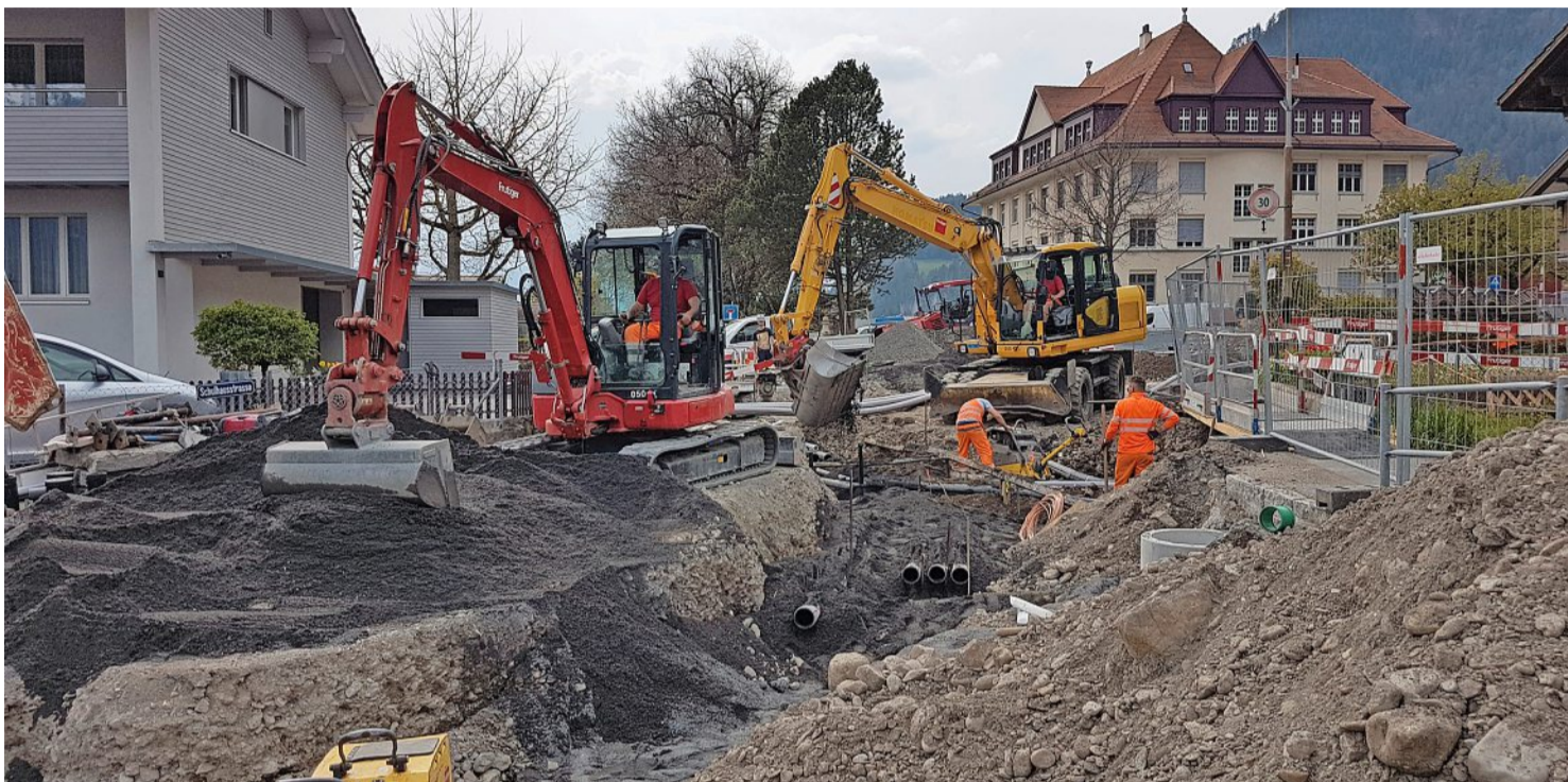
Grosseinsatz bei der Kreuzung Schulhaus. Rechtzeitig auf den gestrigen Schulanfang waren die Gräben aber wieder zugedeckt. Foto: Ueli Flück
